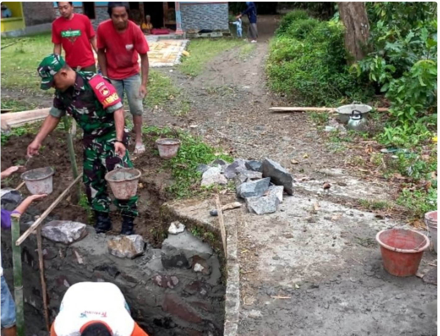
Tingkatkan Perekonomian, Babinsa Koramil 19/ Kuwarasan Karya Bakti Pembangunan Jembatan
