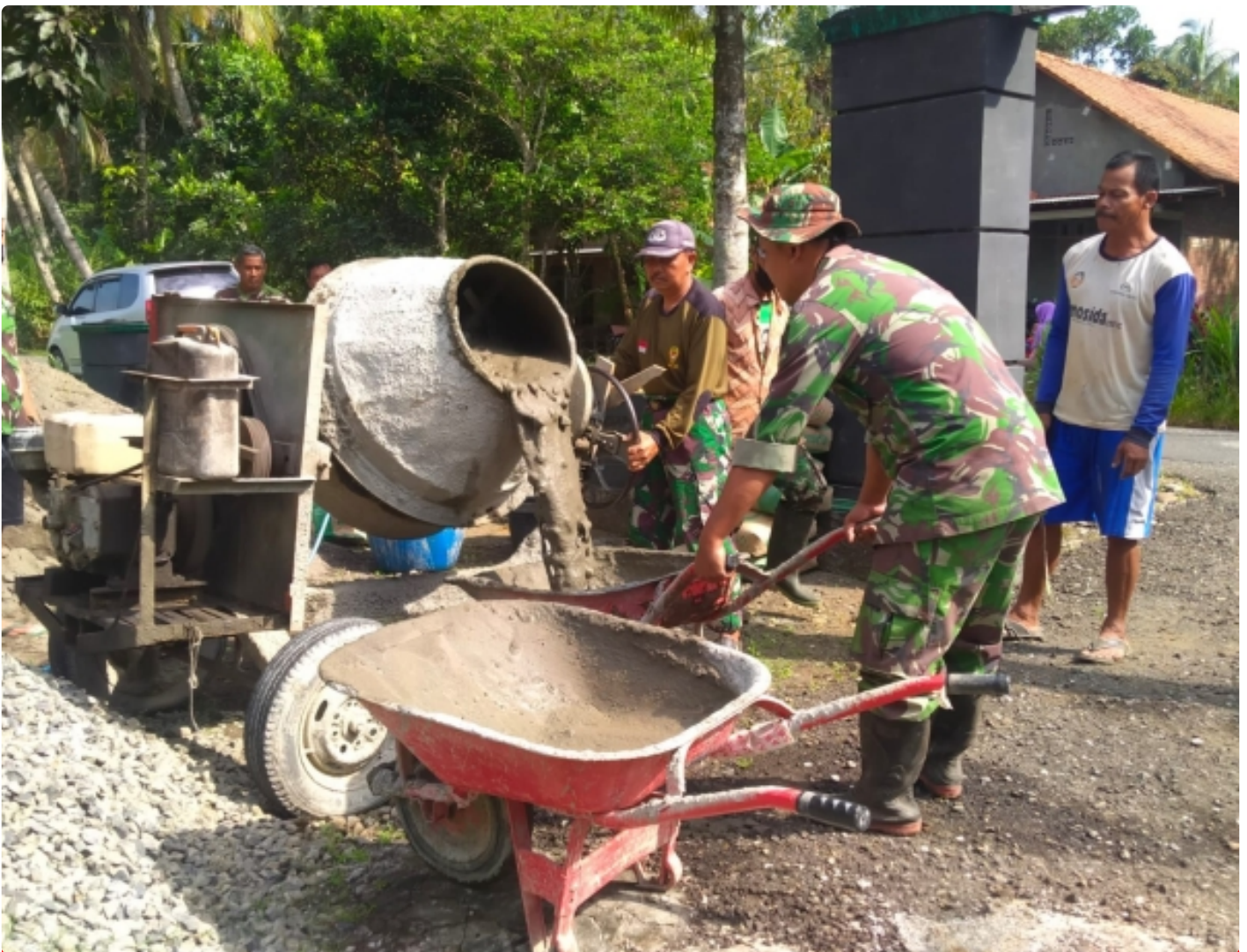
Anggota Posramil Bonorowo Bantu Warga Pengecoran Jalan
